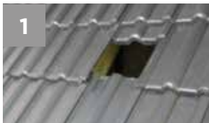
Dachziegel nach oben schieben
